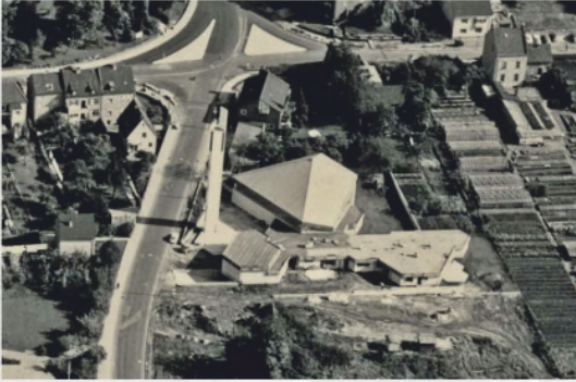
Das Luftbild der Kreuzkirche entstand 1966, also noch während der Bauzeit. (Stadtarchiv Kerpen, Fotos. Nr. 2669)
